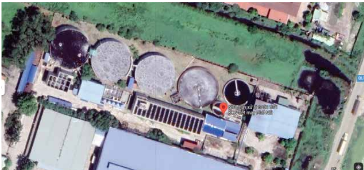
Nhà máy xử lý nước thải tập trung KCN Phố Nối (Hưng Yên) giai đoạn 1, công suất 10.000m 3 /ngày đêm (Nguồn: Google map)
