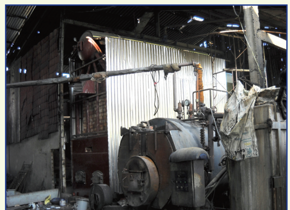
Lò hơi cũ đốt than và lò hơi mới đốt trấu giá 1,6 tỷ đồng (đang đầu tư): giúp giảm 100% khí thải CO 2
