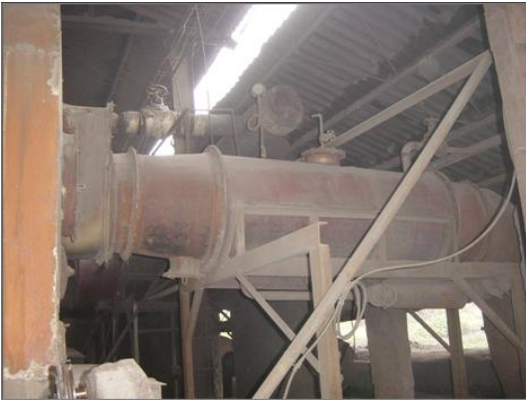
Bộ phận tận dụng nhiệt khói thải của lò hơi ở Công ty Giấy Việt Trì đã thu hồi vốn đầu tư trong 7 tháng
